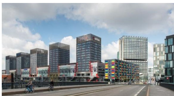
Figure 121. Le centre commercial d'Euralille signé Jean nouvel.
