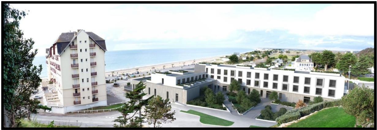
Figure 35 : vue générale sur le centre de thalassothérapie Donville-les-bains
