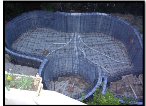
Figure92 : réalisation d'une piscine en béton armé
