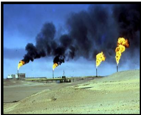
Figure II.35: Zone industrielle de Béthioua
