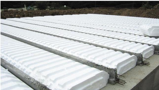
Figure 23 : Isolation thermique des planchers et plafonds
