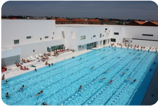
Fig66. Une piscine extérieure chauffée et sportif de 50m de long par 21m de large
