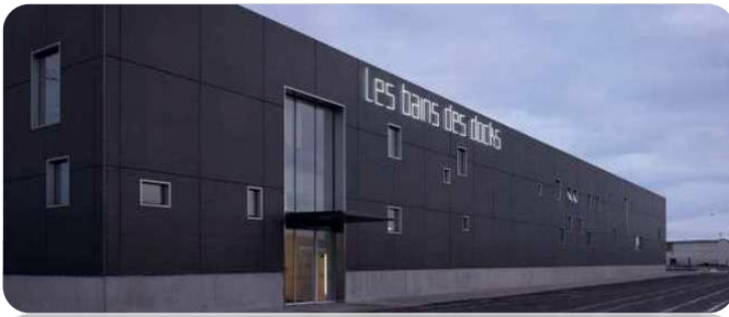
Fig62. Les bains de docks
