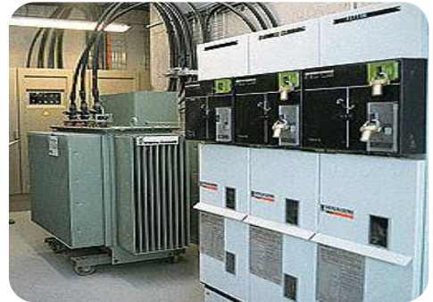
Fig247. Poste transformateur
