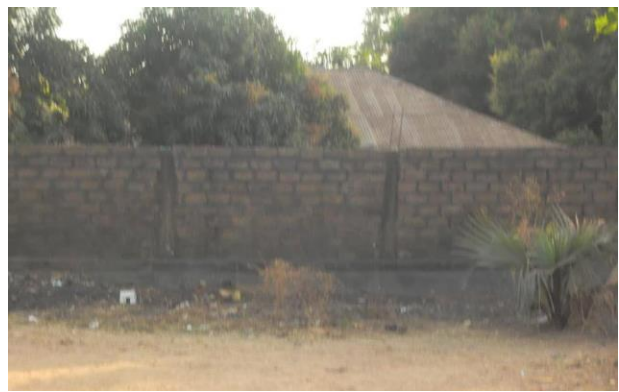
Figure 70. Vue sur le côté Sud-Ouest
