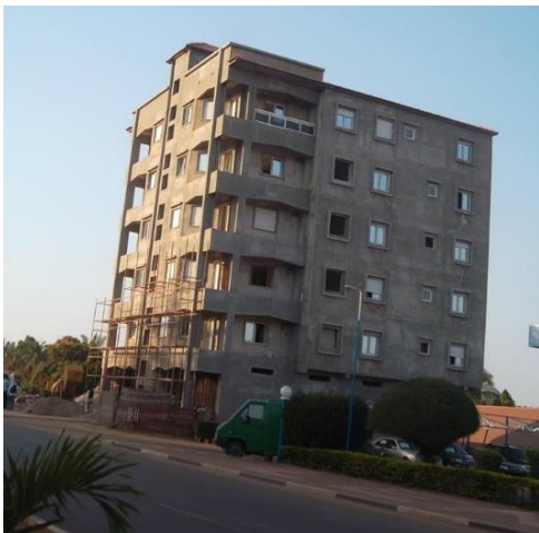
Figure 71. Vue sur le côté Nord-Est
