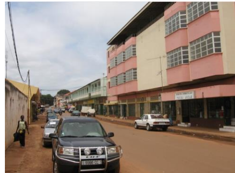
Figure 54. « Rua Vitorino Costa »
