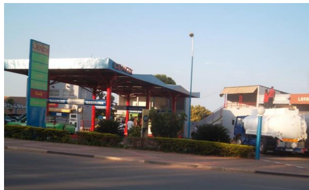
Figure 72. Vue sur le côté Nord-Est
