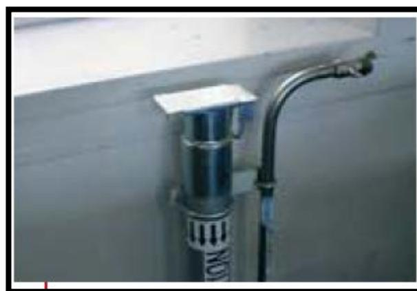
Figure 158. Aspirateur centralisé et point d'eau pour nettoyage
