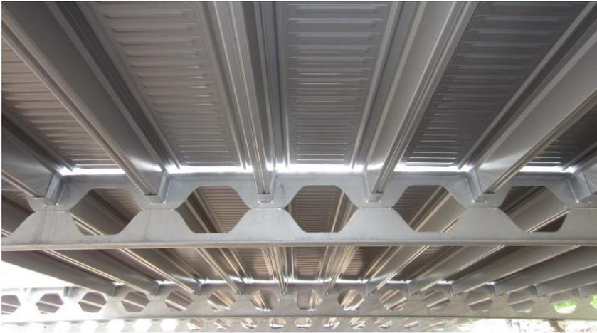
Figure 126 : assemblage poutre alvéolaire avec plancher collaborant
