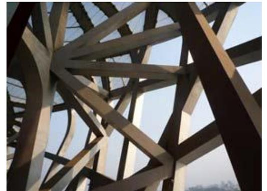
Le stade est en béton recouvert d'acier, seule la structure extérieure est en acier.
