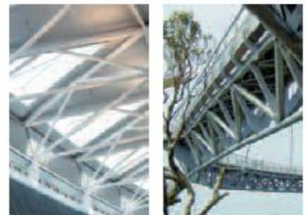
figure 134 : : différentes formes de poutres tridimensionnelles
