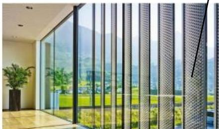
**Figure 152 :** Brises solaires a lamme orientable
