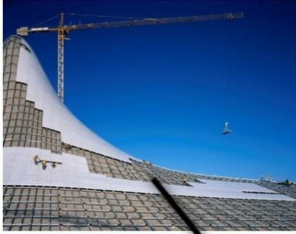
Figure 160 : panneaux en béton reposé sur la structure tridimensionnelle
