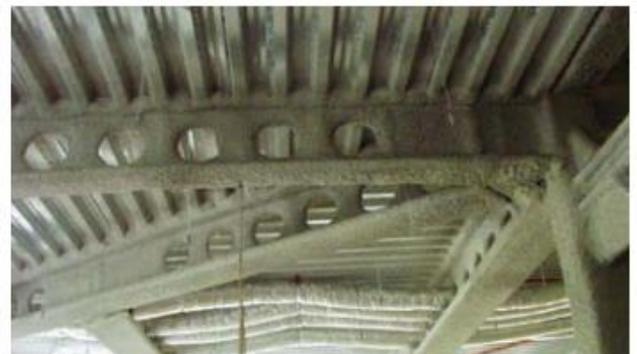
Figure 123: protection par flocage d'une poutrelle ACB
