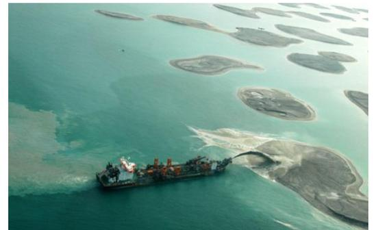
Figure109 : La technique de réalisation, de remblai a l'aide des bateaux
