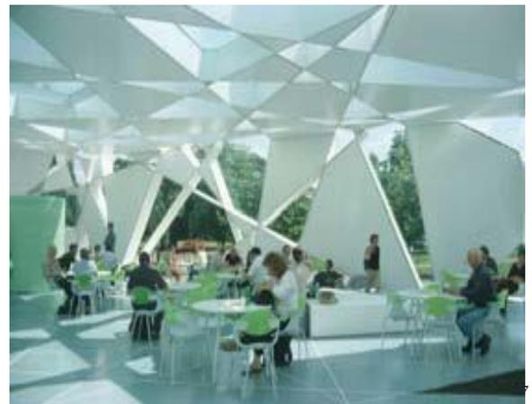
la structure principale est réalisé avec l'acier structurel et recouvert d'un tissu structurel fabriqué spécialement sur la base de panneau coloré et polymère transparent
