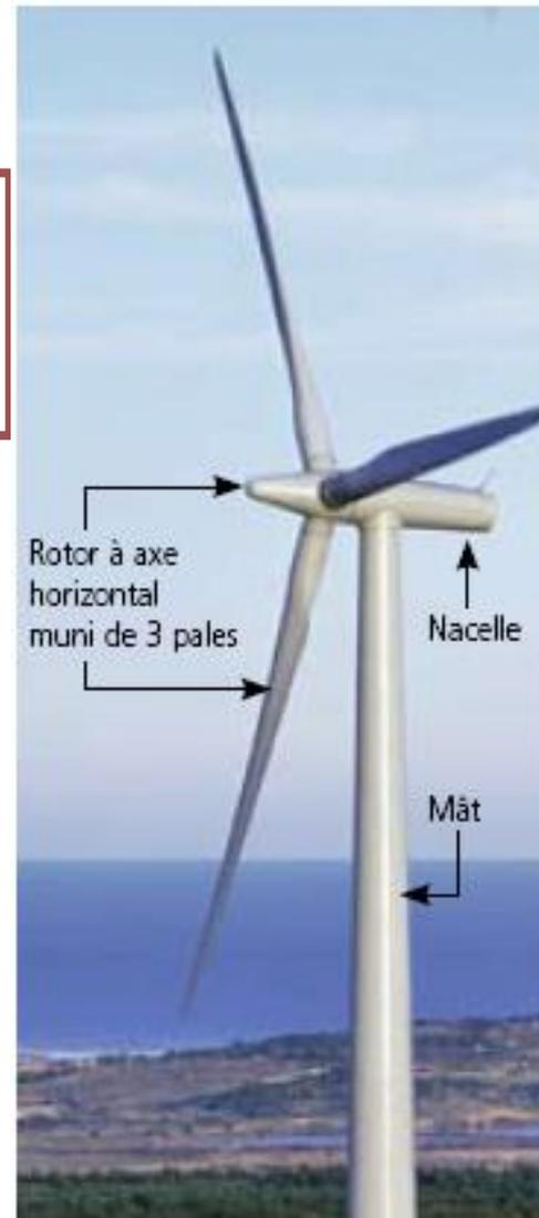
Figure 169: éléments constitutifs d'une éolienne
