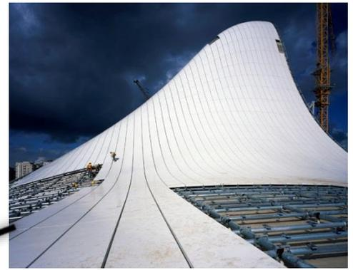
Figure 161 : Construit avec des panneaux de béton renforcé aux fibres de verre et polyester renforcé aux fibres de verre).
