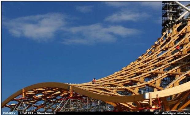
**figure 26** :Structure d'un toit en bois
