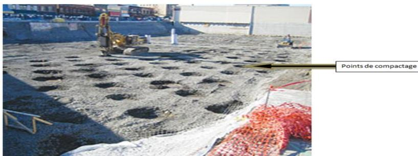
**Figure 113 :** chantier de compactage
