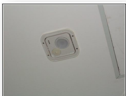
Figure 71: détecteurs de mouvements et détecteurs thermiques
