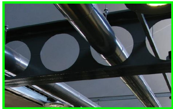
Figure 60: Poutres alvéolaires
