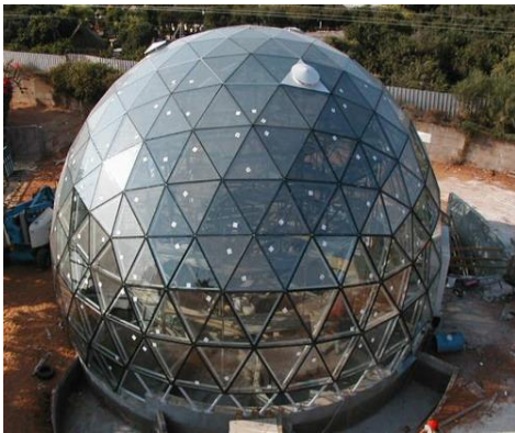
Construction en dôme
