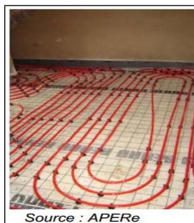
**Figure VI.24 : le chauffage par le sol et les murs**
