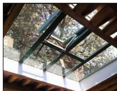
Figure VI12: Exemple de verrière à ouverture
