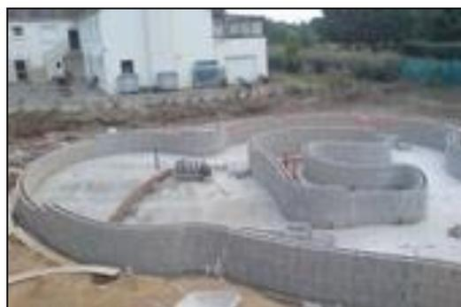
**Figure VL15 :** Piscine avec structure en béton armé.
