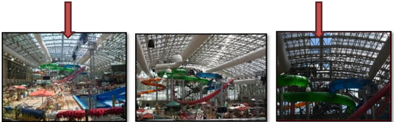
Figure 15 : toit ouvrant du parc aquatique
