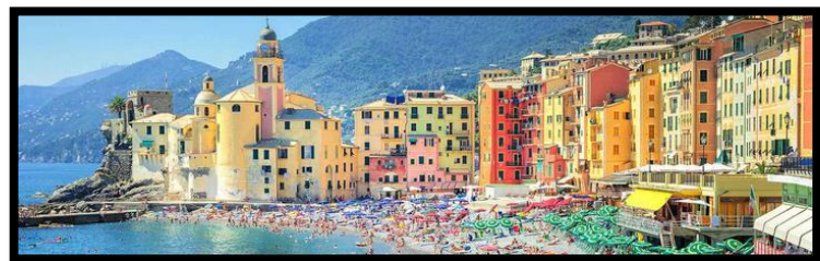
Figure 23 : la ville de gênes après la restauration
