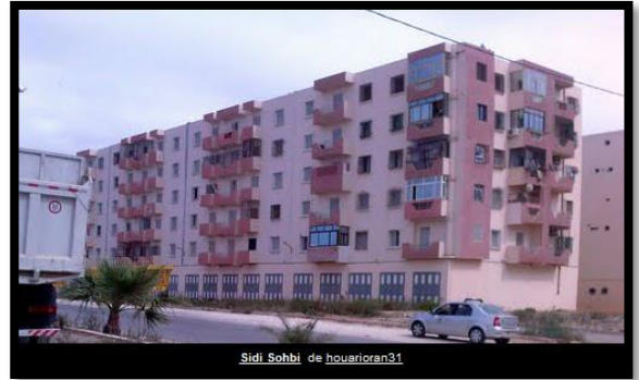
Figure 109 : quartier sidi sohbi R+5
