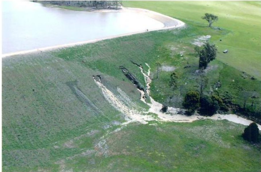
Figure 1 : Rupture par Erosion interne de la digue de Tunbridge, Tasmania – Australia (2008). (Source : http://www.geoengineer.org/ )
