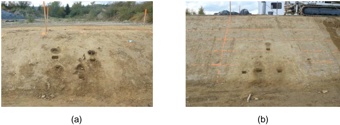
Photo 3.2 : Ouvrage expérimentaux du CER Rouen; (a) : Ouvrage non-traité ; (b) : Ouvrage traité.
