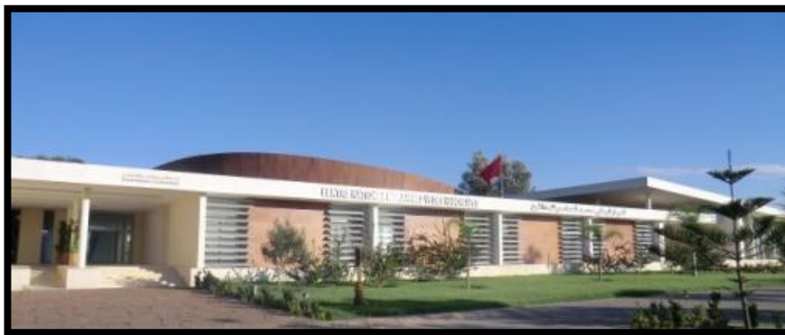
Figure 19 : vue extérieur du centre Mohamed VI 43
