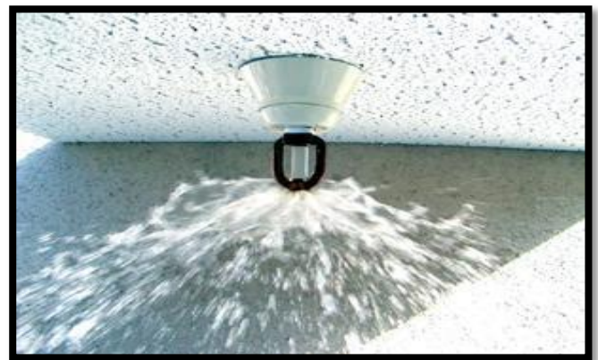
Figure 91 : extincteur automatique 110
