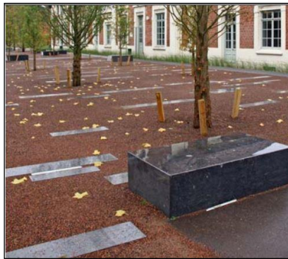
Béton bitumineux rouge à usage placette public (placette mal)
