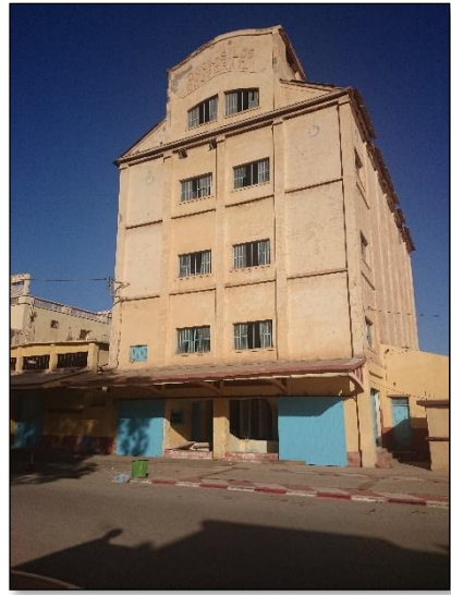
Figure 58. Bâtiment Usine de Blais
