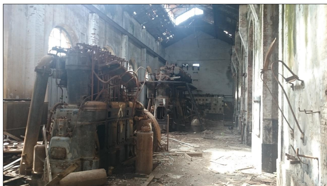
Figure 56. Central électrique Beni Saf 2016 154
