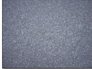
Béton bitumineux noir renforcer
