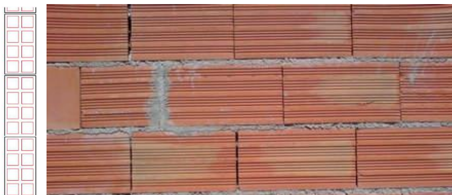
Figure 82: Mur en maçonnerie
