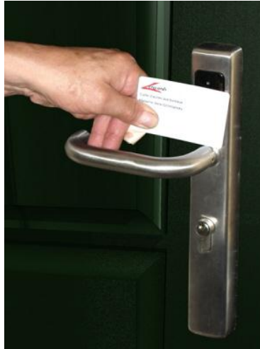
Figure 91: portes équipées avec des serrures de carte à puce
