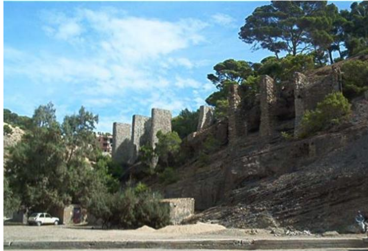
Figure 19: Murs porteurs qui supportaient les chemins de fers
