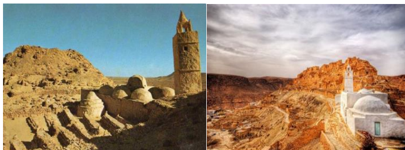
FIGURE 14 : mosquée avant et après la restauration
