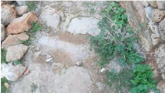
FIGURE 66: revêtement de la ruelle en pierre
