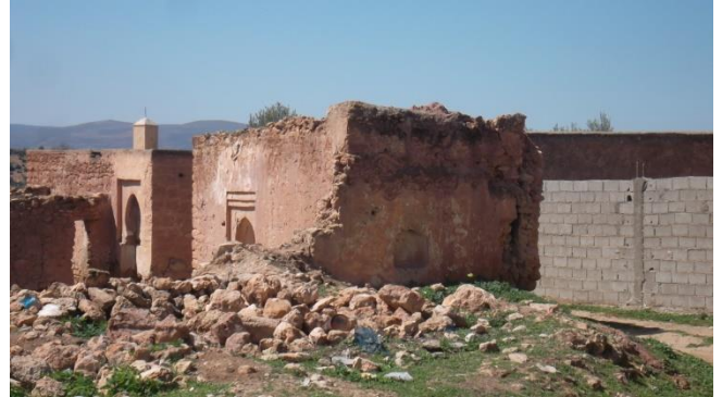
FIGURE 45: habitat vernaculaire en ruine
