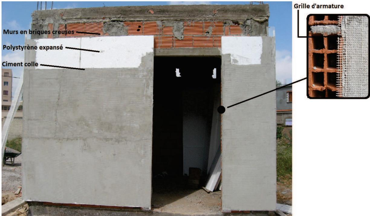
FIGURE 2.11: Photo des différents composants du mur
