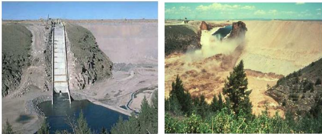
Barrage avant la rupture
