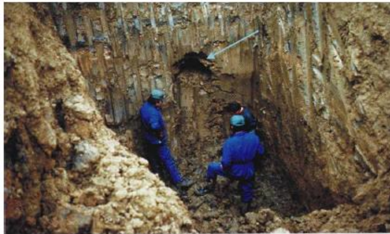
Figure 3.16 : Renard vu de l'aval sur le barrage de Buget (Lautrin, 2002)
