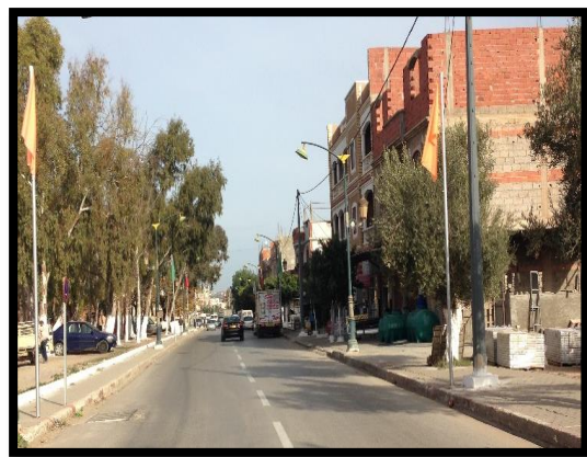
Figure 48. Accès qui mène vers Tlemcen (source :auteurs)
