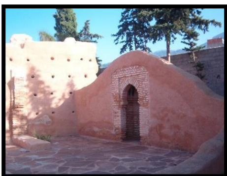
Figure 21. Vestige de ksar sidi sultane (Source : Auteurs, photo prise le 12/11 /15)
