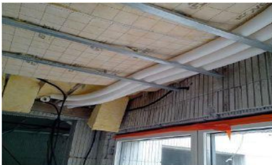
Figure : passage des équipements au-dessus d'un plafond suspendu
