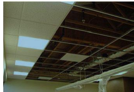
Figure : passage des équipements au-dessus d'un plafond suspendu
