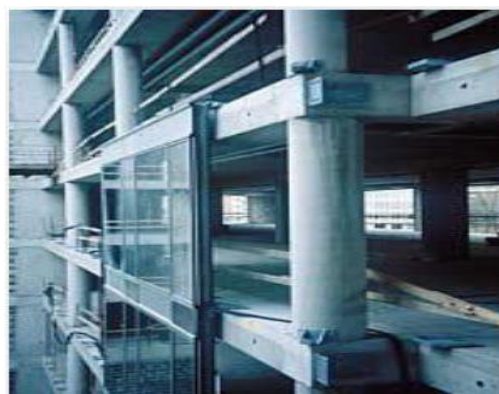
Figure 3 : installation des panneaux
