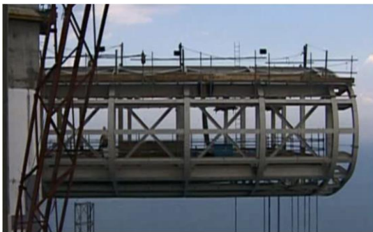
Figure : l'enveloppe métallique
