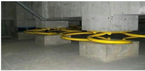
Figure :les amortisseurs antis parasismiques
