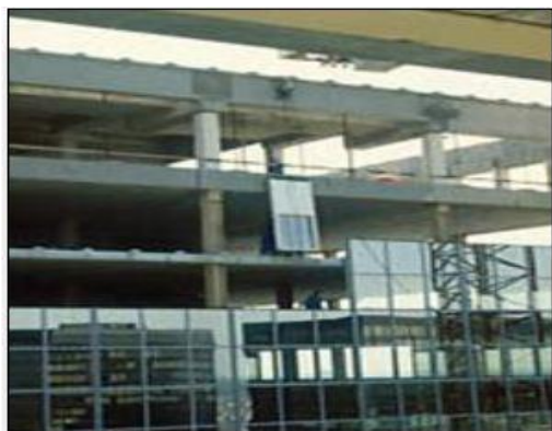
Figure 4 : l'installation de mur rideau
