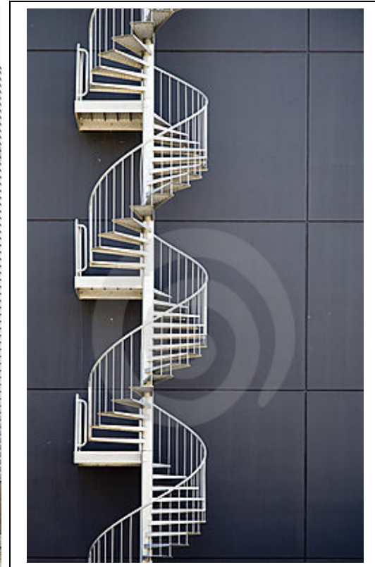
Figure 195:escalier de secours
