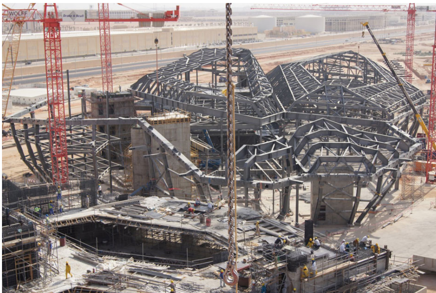
Figure 18 : Le projet de l'exemple 02 au cours de réalisation
