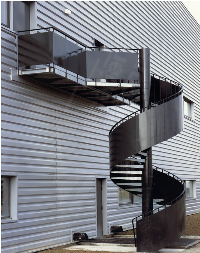
Figure 194: escaliers de secours
