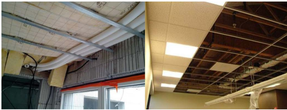
Figure 146: faux plafond des laboratoires
