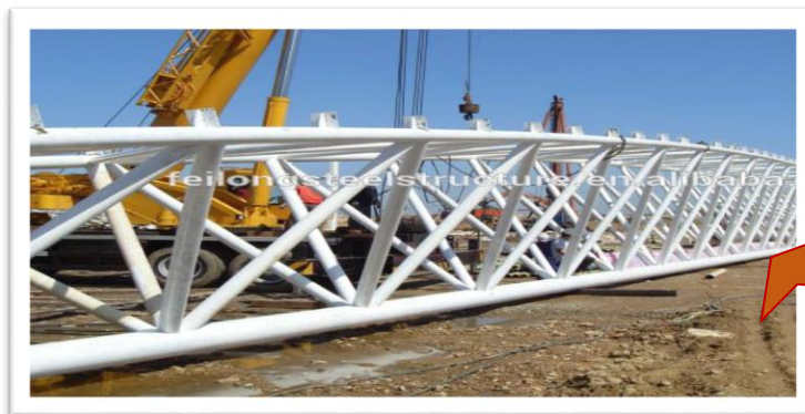
Figure 132: poutre de rigidité
