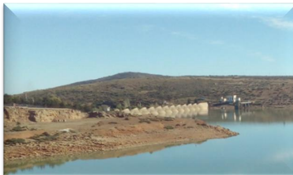
Figure 64: la digue du barrage
