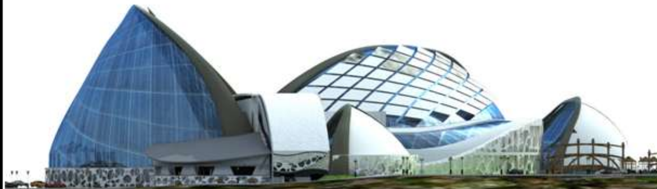
FAÇADE NORD OUEST
