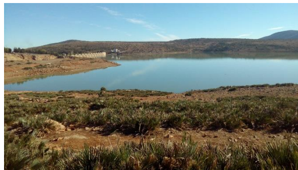
Figure 72: barrage El Meffrouch et la digue 62
