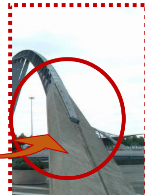
Figure 131: fixation de l'arceau métallique sur la fondation en béton armé.
