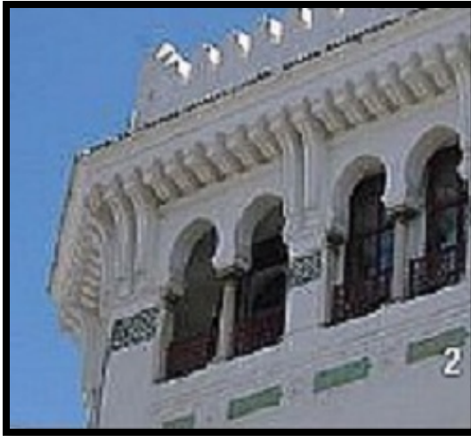
Photo10 : galerie à colonnes jumelées de la grande poste
