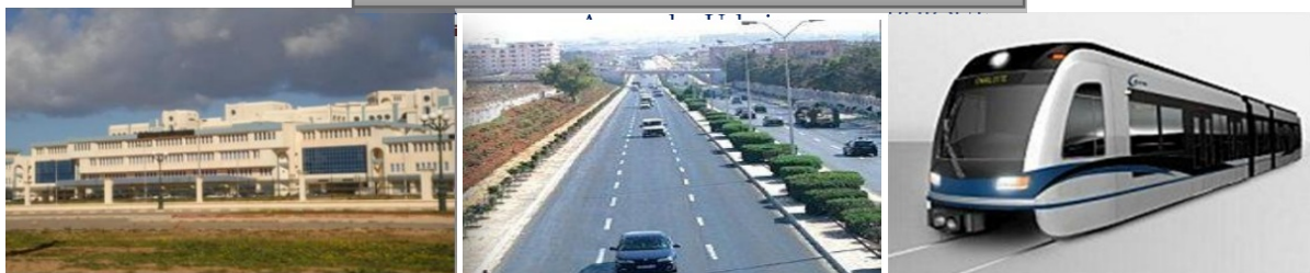
Photos18 : les infrastructures à ORAN
