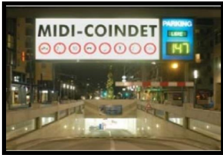
Figure 64: L'accès au sous sol
