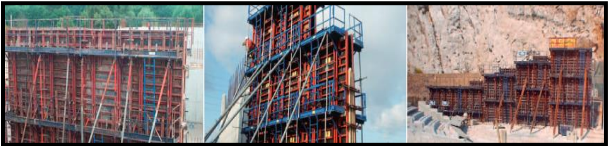
Figure 9:procédés technique préfabriqué table banche
