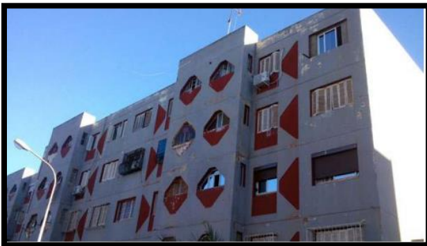
Figure 44: Façade principale d'immeuble source : PDF
