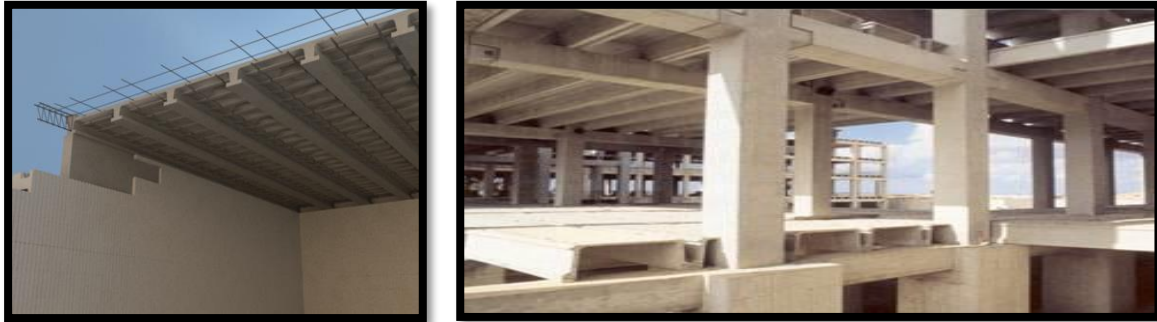
Figure 89: des dalles nervurées source : internet 81
