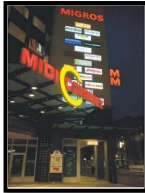
Figure 62: L'accès au centre commercial
