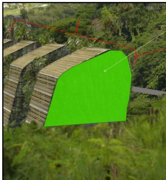
Les murs "sismiques" latéraux ont été développés avec les ingénieurs de l'ARUP comme structure principale des bâtiments.
