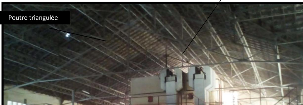
Figure 61 : vue d'intérieur de la charpente métallique
