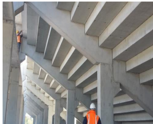
Figure 84 : un tribune en béton
