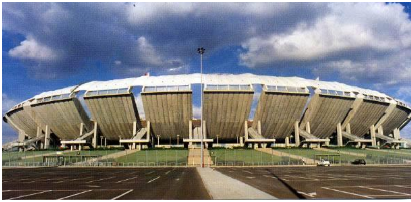
Figure 28 : Stade Saint Nicola à Bari avec une structure segmentée en brèches verticales
