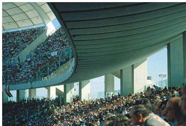
Figure 29 : Ouvertures au niveau de l'enceinte assurant le confort thermique dans le stade
