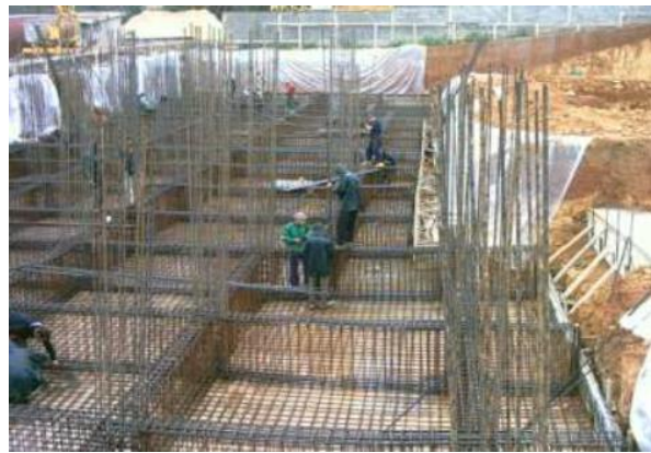
Figure 77: photo de ferrailage de radier nervuré
