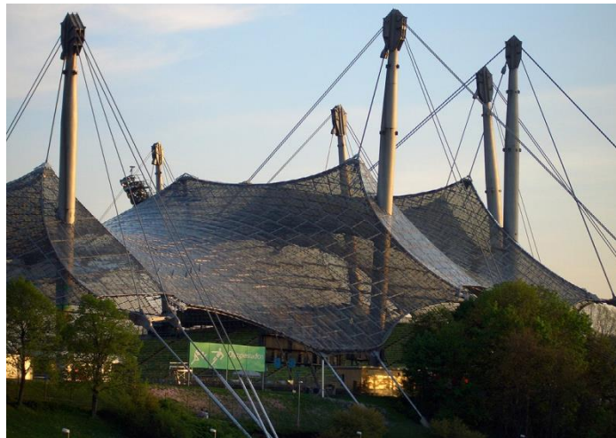
Figure 20 : couverture du Stade olympique de Munich, 1972
