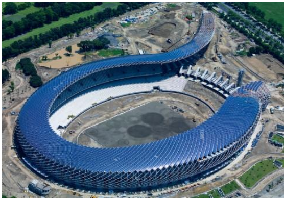
Figure 26 : la toiture en panneaux photo voltaïque Le stade de Maracaña à Rio De Janeiro.
