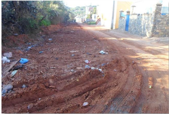
Figure: Voie tertiaire
