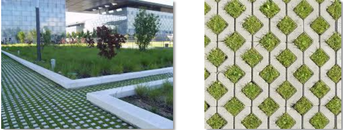
Figure 3 : Pavé de grés de joint engazonné : usages pour placette en dehors des cheminements
