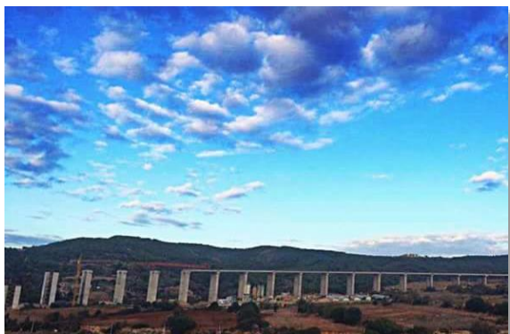
Figure : bretelle d'autoroute
