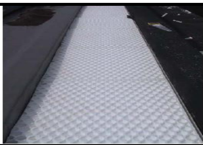
Drainage sous forme de plaques à excroissances en EPS
