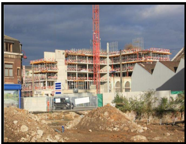
Centre CMI, chantier novembre 2012
