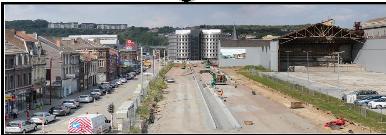
Elargissement de la Rue Cockerill: état d'avancement des travaux, septembre 2014
