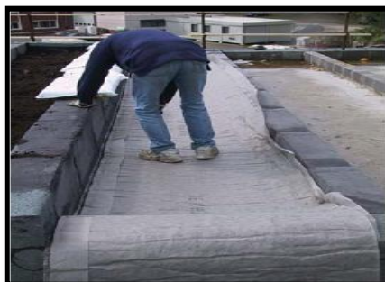
Drainage sous forme de plaques à excroissances en EPS
