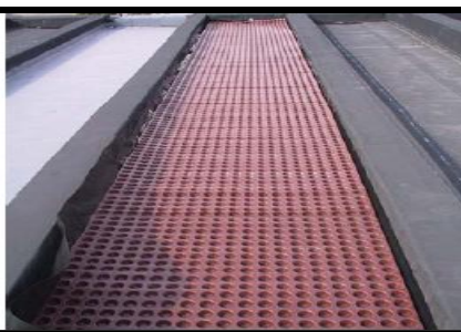
Drainage sous forme de plaques à excroissances en PVC rigide
