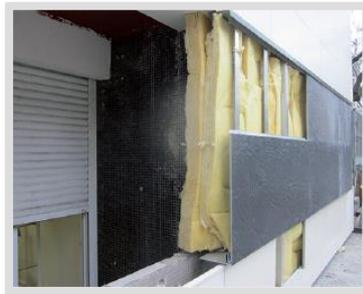
Façade en cours de travaux, bardage aluminium avec laine de roche protégée par des plaques minérales
