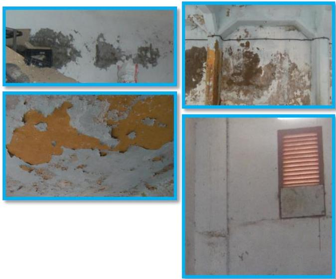
Figure n°50 : représente les différentes pathologies au niveau du bâtiment
