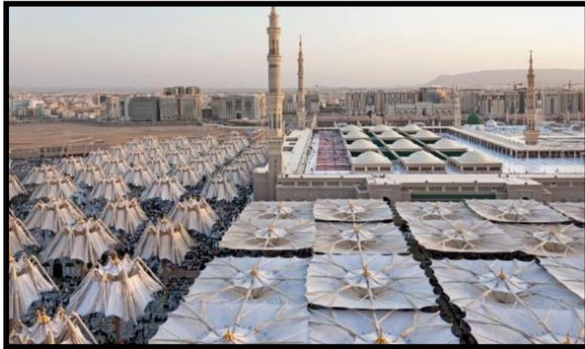
**Figure n°65** : représente les structures tendues (ouvertes) de la mosquée de la médina
