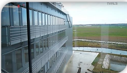
Figure 82: façade du centre EDF
