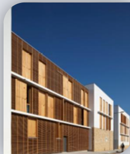
Figure 45: bardage en bois
