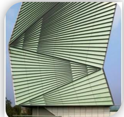
Figure 114: les replis de la façade Source : http://www.tekneco.it
