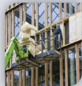
Figure 44: isolation des façades par la laine de roche
