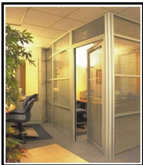
Figure 84: système de séparation par cloison vitrée
