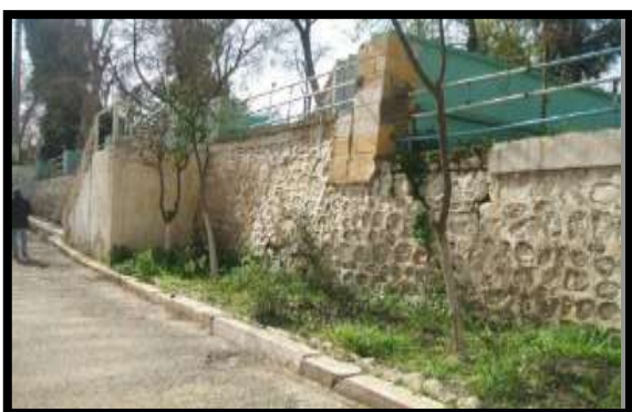
Figure 54: murs de soutènement
