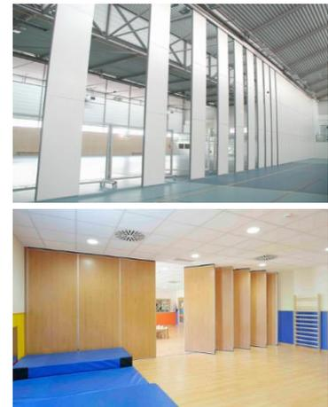
Figure 148:Cloison mobil entre les salles de sport
