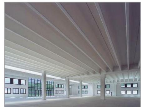
Figure 141:Hall de sport en plancher nervuré
