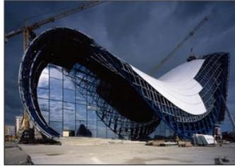
Le revêtement de la structure métallique se fait par le matériau : béton renforcé de fibre de verre (composite ciment verre)
