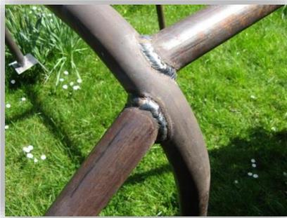
**Figure 98.** Photo de l'intersection en gueule loup d'éléments métalliques
