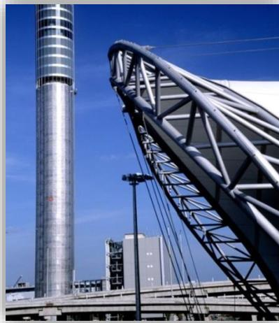
**Figure 97.** Photo d'un arc tridimensionnel d'un hall d'exposition (Marseille, France)
