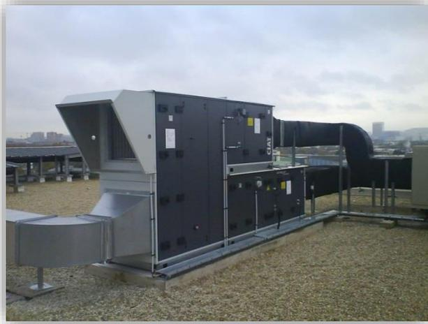
**Figure 103.** Photo d'une centrale de climatisation de l'aéroport Mérignac (Bordeaux, France)
