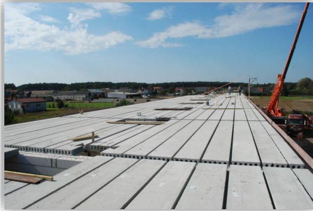
**Figure 94.** Photo d'un plancher alvéolé
