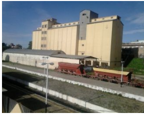
Les docks silos
