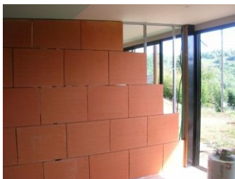
Figure 42 : cloisons en brique
