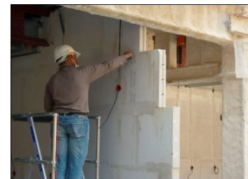
Figure 43 : cloisons en béton
