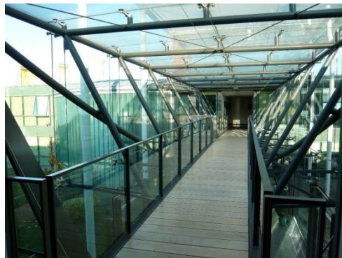
Figure 59 : Passerelle panoramique Source : http://www.saint-eloi.eu/construction-metallique
