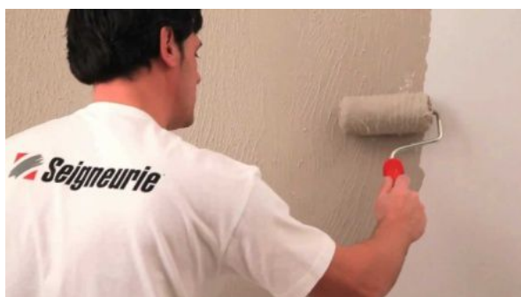
Figure 35 : Application de la peinture
