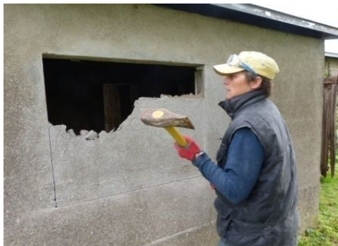
Figure 28 : Création des ouvertures Source : http://sarlcavalli.e-monsite.com/
