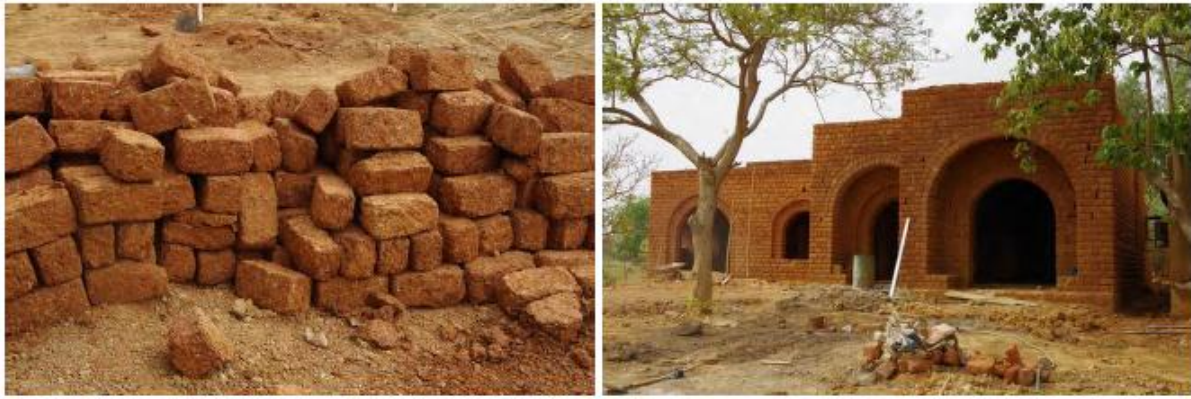
Figure 1.11 : Construction en blocs découpés, Burkina Faso (Paulus, 2015).
