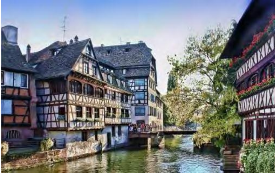
Figure 1.14 : Constructions en torchis ; Strasbourg, France (Paulus, 2015).
