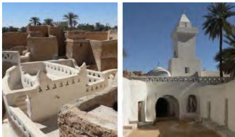
Figure 1.6 : Constructions en adobe ; Ghadamès, Libye (Paulus, 2015)
