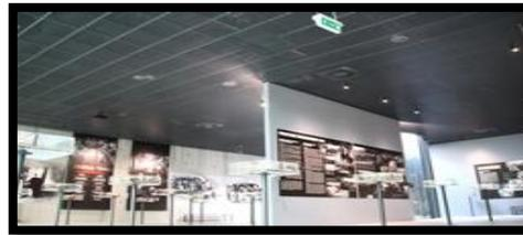
Figure211 : Les faux plafonds en aluminium.
