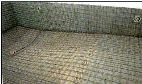
Concernant les bassins, on a préconisé l'utilisation d'une cuve en béton armé désolidarisée de la structure, afin d'obtenir une meilleure répartition des charges. Les parois seront constituées de voiles en béton arme, le fond du bassin sera posé directement sur le bon sol qui est apte à le supporter.
