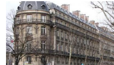
Figure 23 bâtiment de l'époque industrielle
