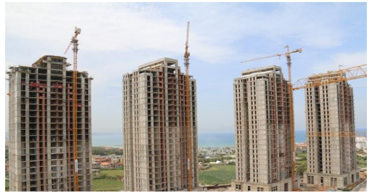
Figure 153 : forum el Djazair en cours de construction
