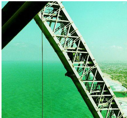
Figure 185: les méga colonnes sont une structure en acier recouverte d'aluminium
