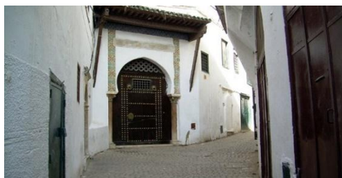
Figure 126 : La casbah d'alger
