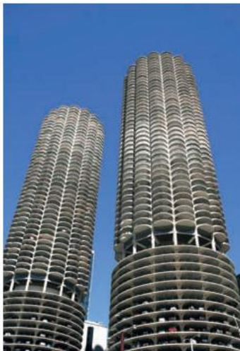
Figure 92 : les tours de Marina City ,USA,Chicago, 1964
