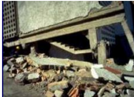
Figure 10 : éviter les colonnes courtes
