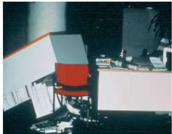
Photo 48: Les armoires de classement risquent de basculer, surtout si les tiroirs à roulettes ne sont pas retenus par des dispositifs adéquats
