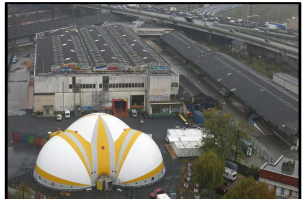
Photo 06 : le centre d'hébergement après l'accueil
