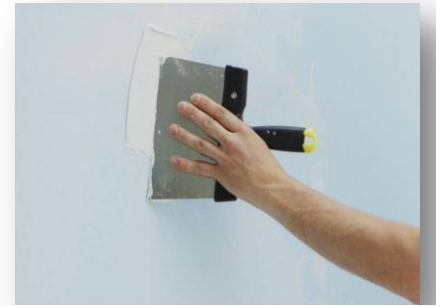
Photo 46 : revêtement d'enduit pour LISSER en EPAISSEUR
