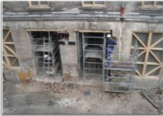
Photo 13 : le centre durant la réhabilitation
