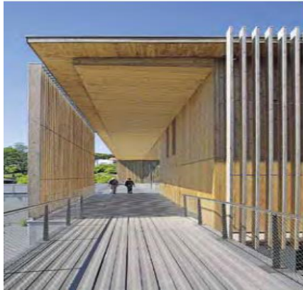
Figure 15 vue extérieur de médiathèque
