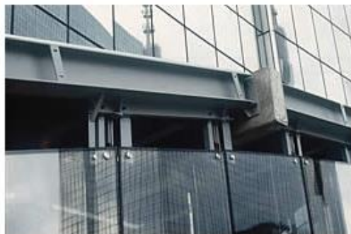
Figure 120 bâtiment utilise mur rideau en verre structurel
