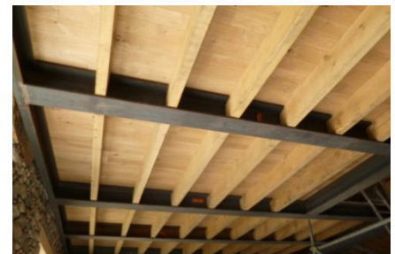
Figure 23 plancher en bois posé sur des poutres en acier
