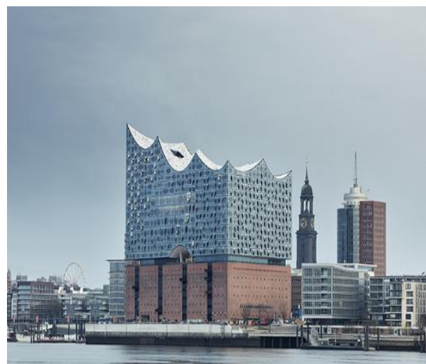
Figure 32 Vue Extérieure du centre
