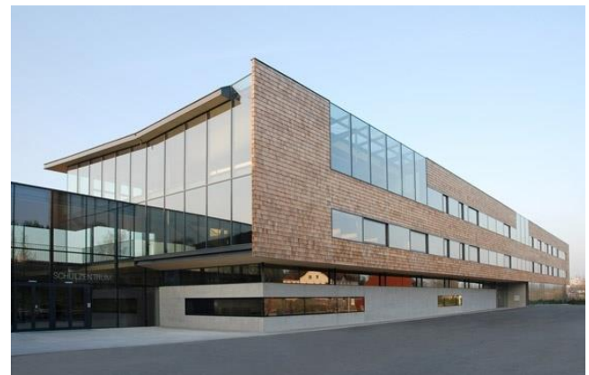
Figure 27 La façade du centre scolaire
