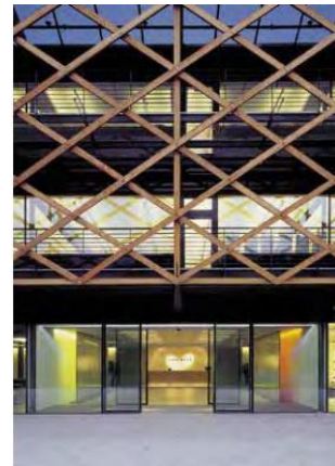
Figure 32 vue extérieure du centre
