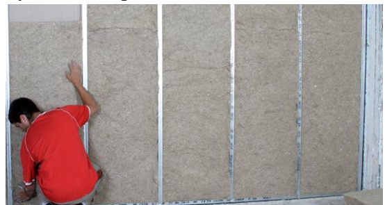
Figure 116 Séparation par des cloisons de distribution
