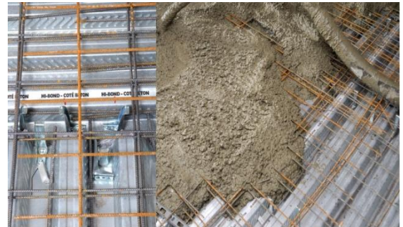
Figure 111 Plancher collaborant dans le bâtiment
