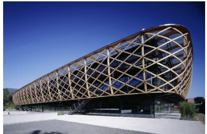
Figure 30 La façade du centre
