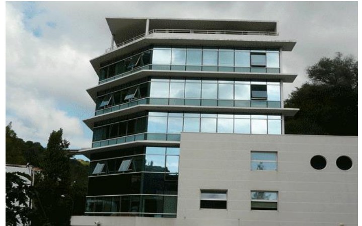
Figure 58 la façade Sud ouest d'institut
