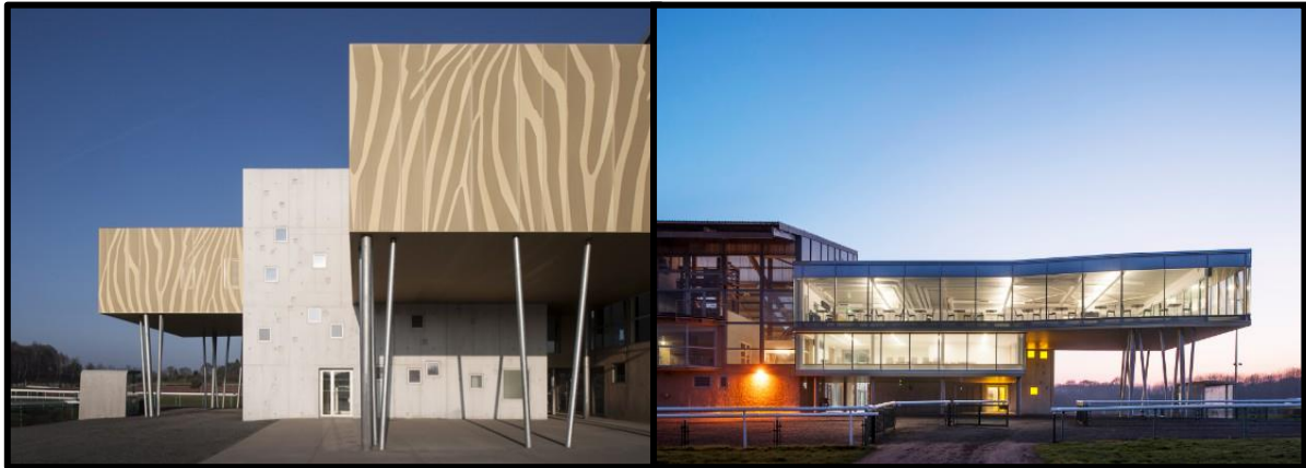
Figure 13 les poteaux métalliques remplis de béton élancé
