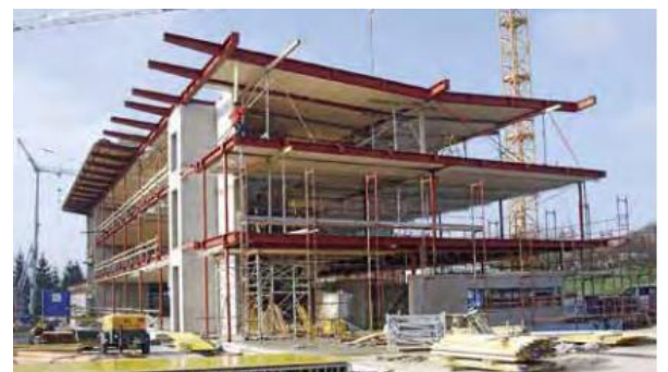
Figure 28 La méga poutre qui franchit le vide du gymnase sur deux niveaux
