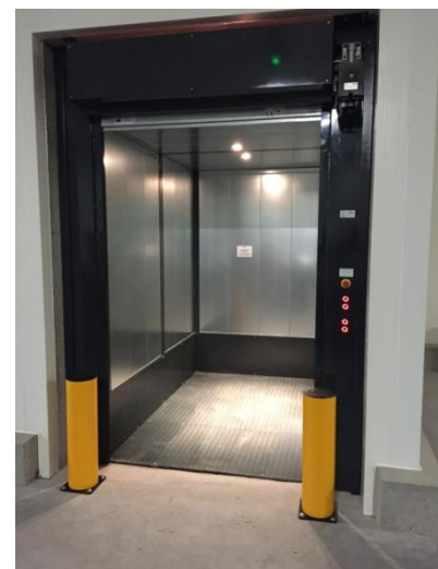
Figure 135 le détail de monte charge
