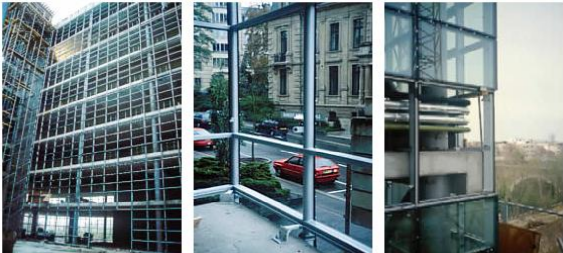
Figure 117 Les bâtiment en mur rideau monte sur grille
