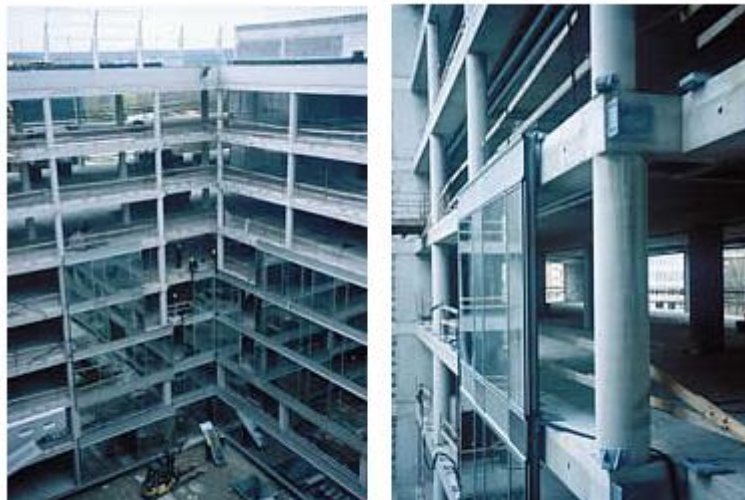
Figure 119 bâtiment utilise mur rideau monte un panneau
