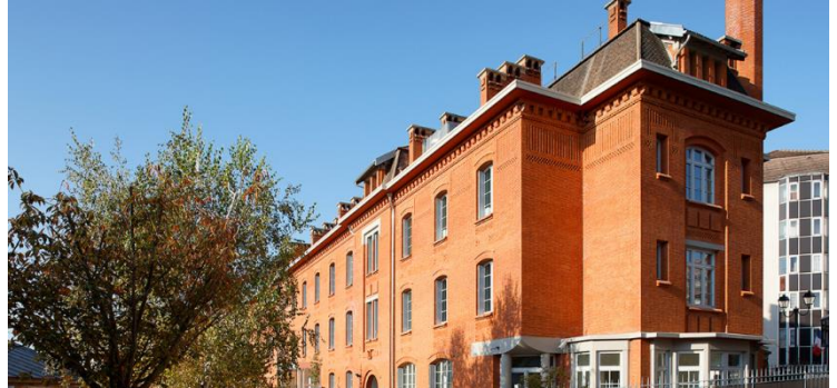
Figure 54 la façade ouest de l'institut
