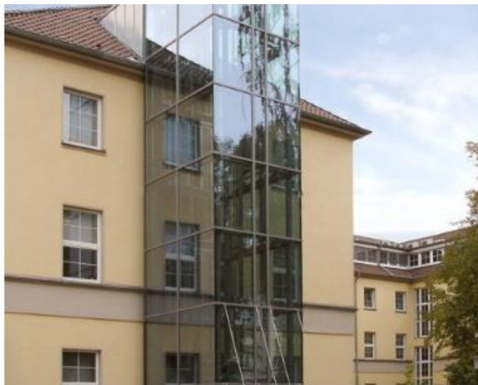
Figure 121 Utilisation de mur rideau au niveau de cage d'escalier
