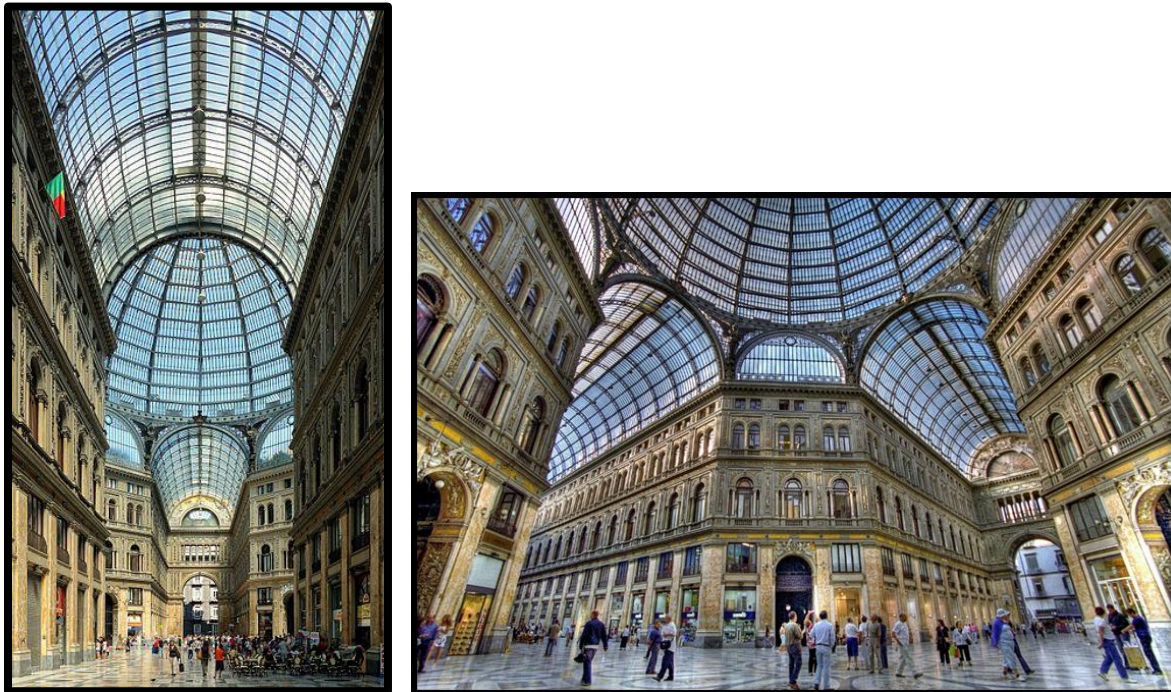
Figure 46 : vue intérieure de la galerie
