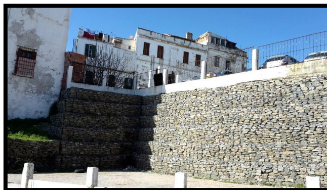
Figure 37 : vue sur le 2eme terrain qui montre la déférence de niveau 1
