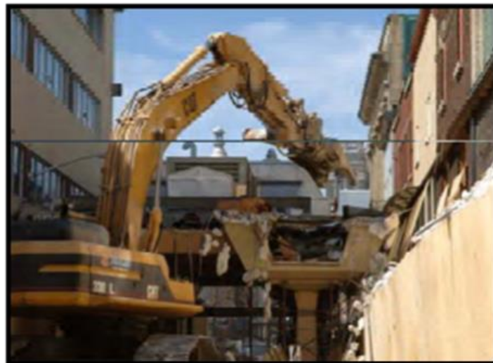
Figure 22 : la démolition du Mail de Saint-Roch 2
