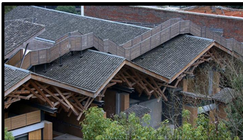
Figure 56 : vue sur le passage par les toitures
