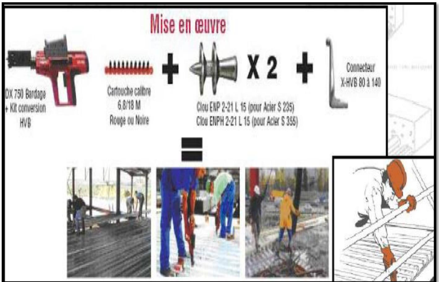
Figure 78 : Fixation du bac
