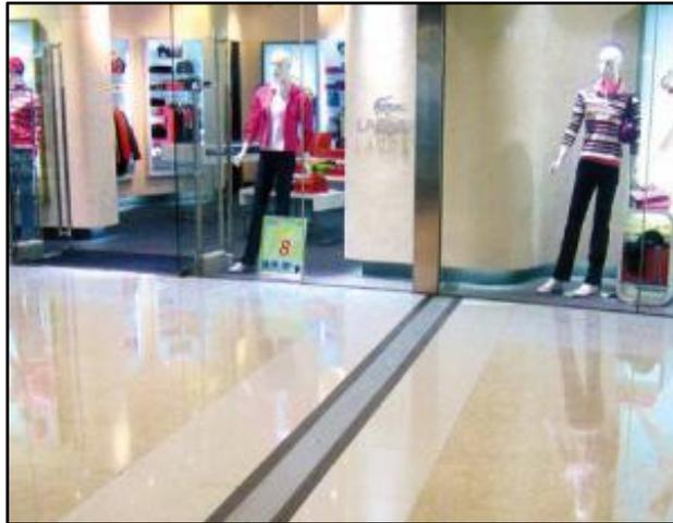
**Figure 106 : Exemple de l'utilisation d'un couvre joint dans une construction**
