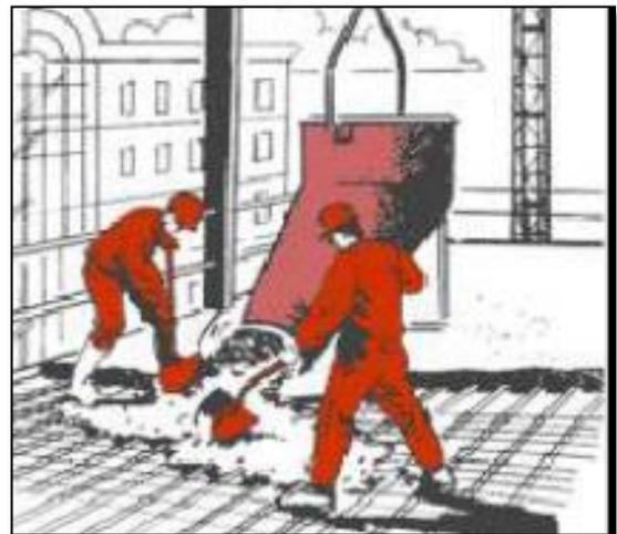
Figure 83 : Coulage du béton
