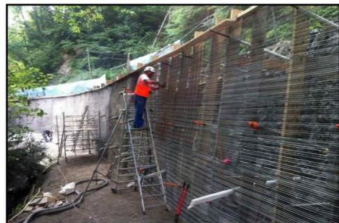
Figure 113 : Détails technique d'un mur de soutènement \_ Figure 114 : La mise en place d'un mur de soutènement
