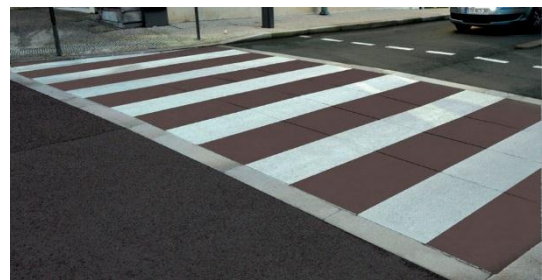
Passage piéton surélevé accessibles
