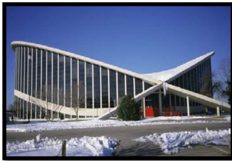
Figure n 16: Toitures suspendues
