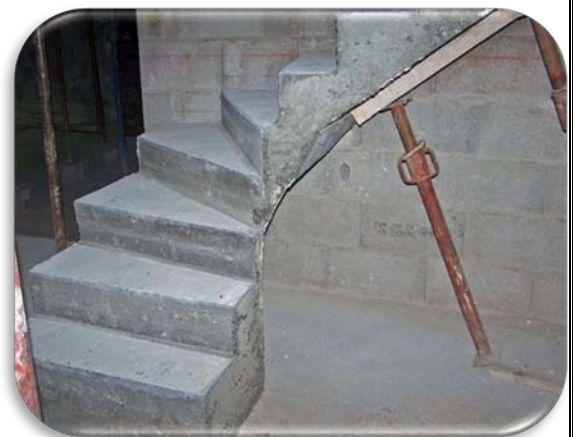
Figure n200 : Structure en béton armée
