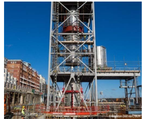
Figure n 222 : la réalisation du tube métallique
