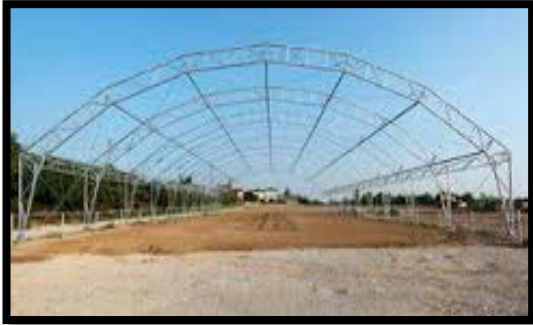
Figure n 06 : Portique à treillis
