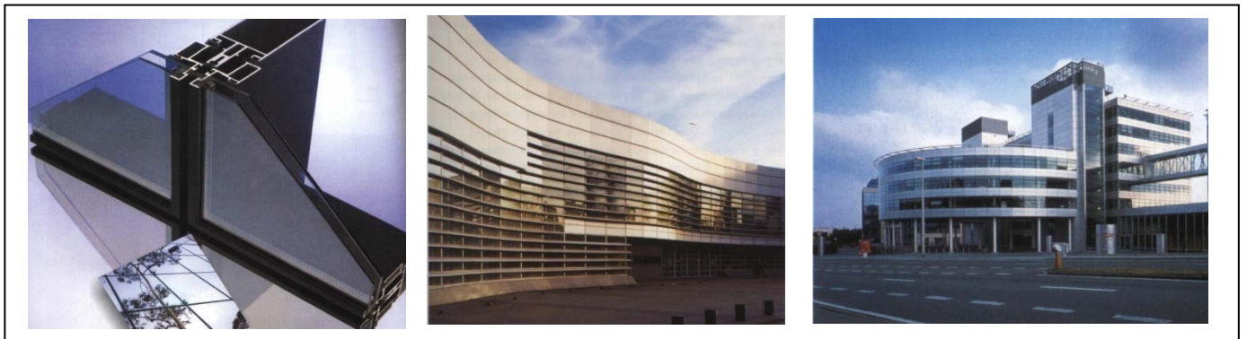
Figure n 08 : utilisation de l'aluminium dans Les enveloppes et bardages
