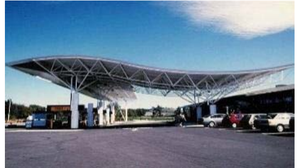
Figure n196 : exemple Structure métallique en triller
