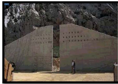
Figure n 14 : mur en béton BAP
