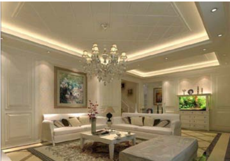
Figure n 213 : exemple d'un Plafond suspendu
