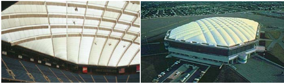
Figure n 15: Les bâtiments avec une structure gonflable sont les structures à grande portée les plus légères
