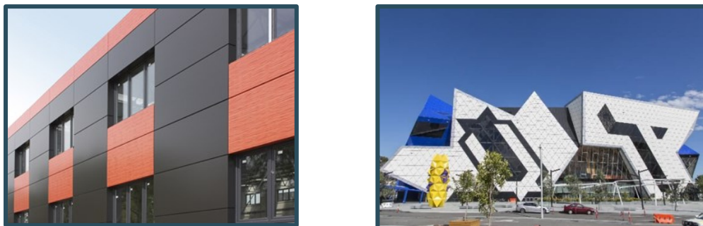
Figure 172 façade en Alucobond
