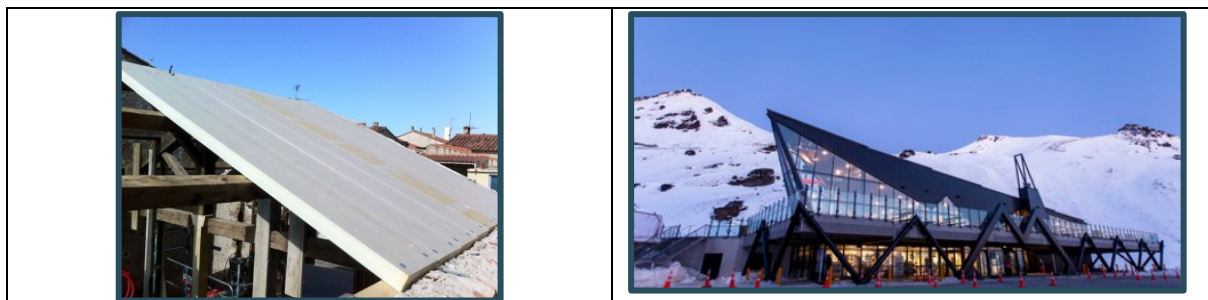
Figure 153 exemple de toiture inclinée en panneaux sandwich
