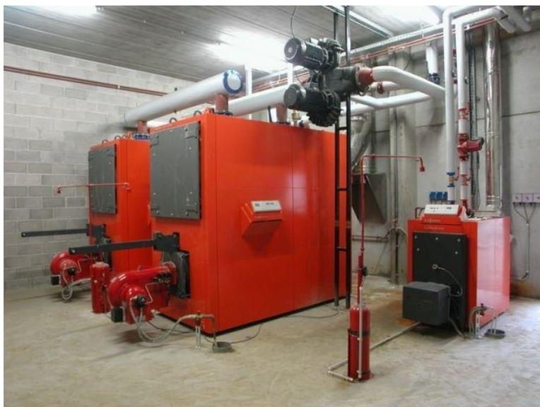
**Figure 74.** Photo des chaudières dans un local technique. (Source: <http://www.solarconcept.be/produits-chauffage-central>)
