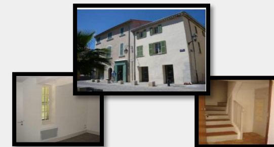
Logements d'urgence avant et après travaux (1 rue Evenos - 10 rue Clément Daniel)
