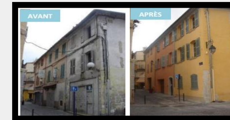
Maison de l'habitat avant et après intervention _ Rue de la République
