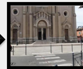
Le parvis de l'église après travaux
